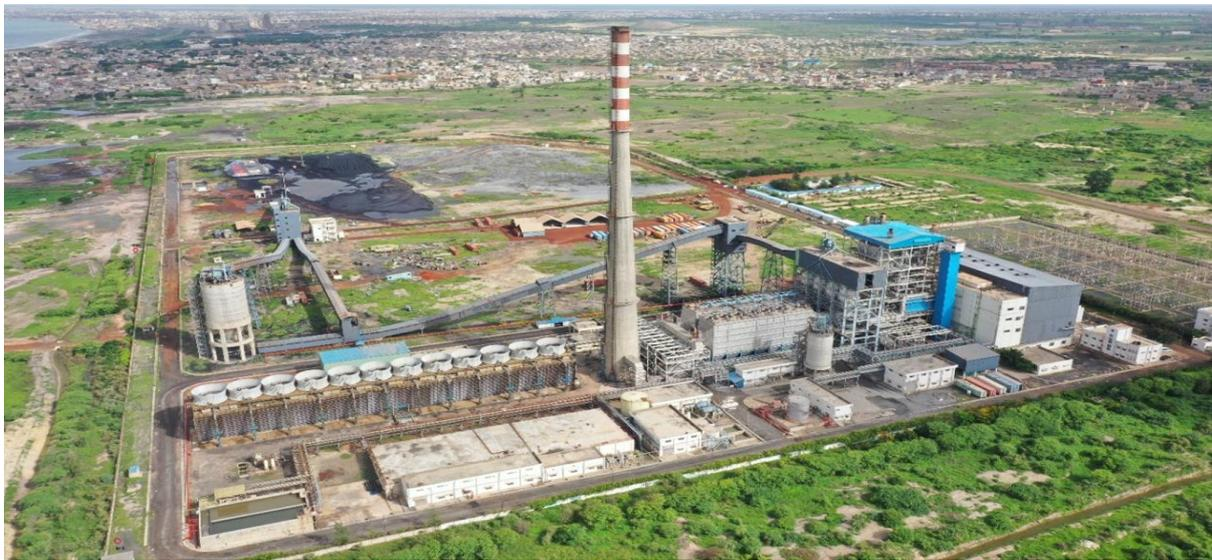
**Photo 1. Centrale électrique de Sendou avec stockage de charbon et décharge de cendres, face à la ville de Bargny.** Source : Sebenzana, septembre 2022.
